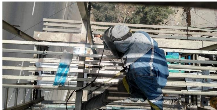
Figura12. Fotografías después de la implementación de un sg-sst II. Fuente: Elaboración propia
