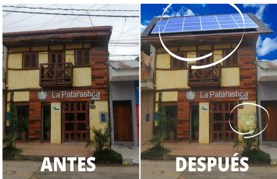
Figura N°8: Implementación del Panel Solar.
