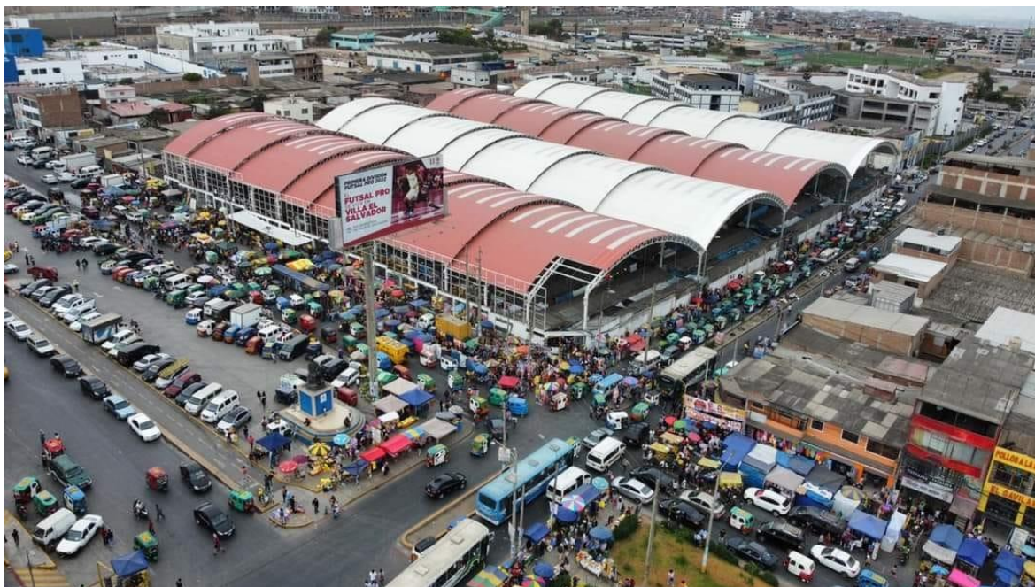
Imagen N. °2. Vista aérea del C.C. Plaza Villa Sur en remodelación
